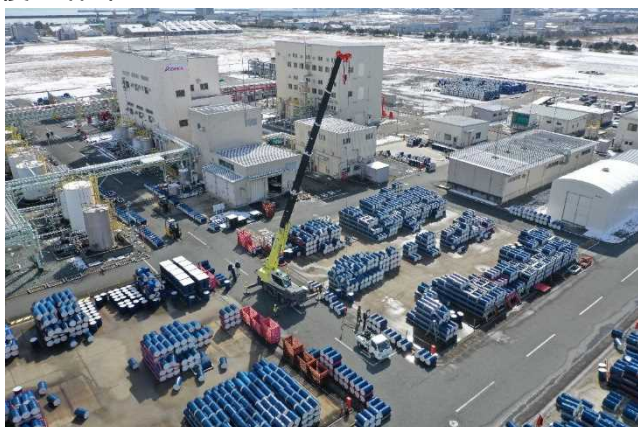
クレーン車で脱落ドラムの復旧
