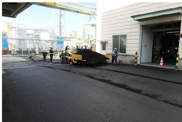
構内道路の舗装工事
