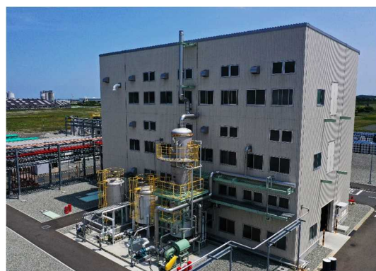
第二生産プラント SA-II 排ガス処理設備
