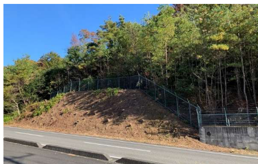
支障木伐採エリア
