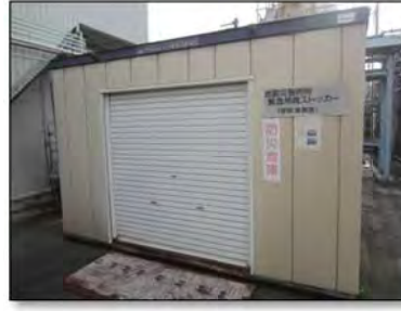
防災備品倉庫
