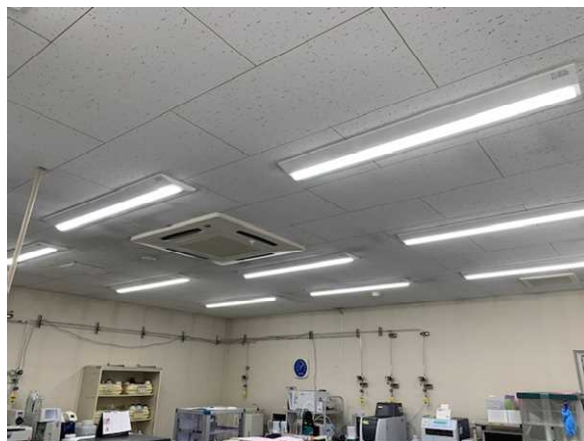
構内照明のLED化を推進中
