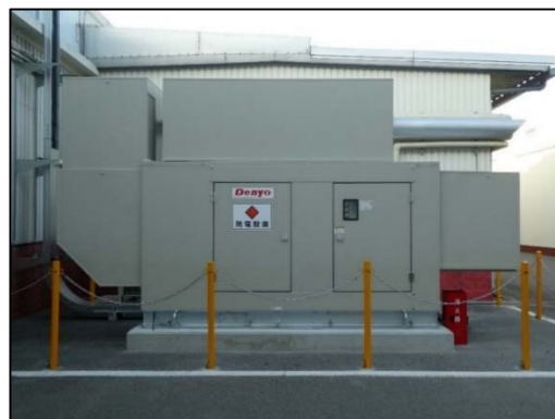
非常用発電機設置
