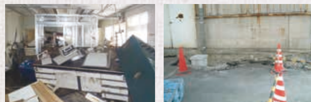
津波による被害を受けた相馬工場 地震により地盤が沈下した鹿島工場
